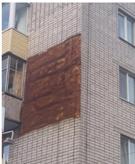
Рисунок 2 – Утепление наружных стен многоэтажных домов с несущими кирпичными стенами пенополиуретаном по ул. Брянского Фронта (а) и проспекту Московскому в г. Брянске (б).
