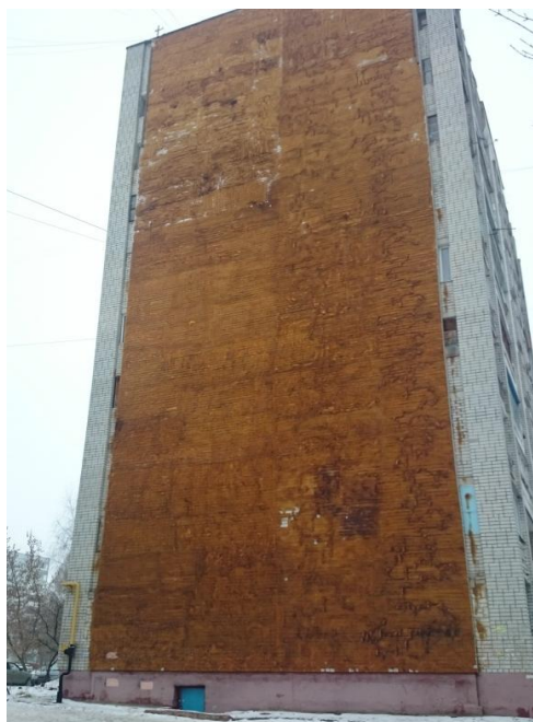
Рисунок 2 – Утепление наружных стен многоэтажных домов с несущими кирпичными стенами пенополиуретаном по ул. Брянского Фронта (а) и проспекту Московскому в г. Брянске (б).
